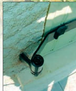
Pliage sur mesure des pentures
